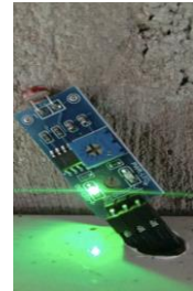
ภาพ 9 แสดงเซนเซอร์ตรวจวัดความสว่าง ความมืดที่ติดตั้งภายในโรงเรือนโคนม
