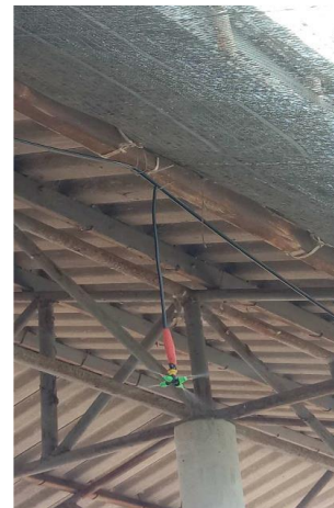
ภาพ 11 แสดงการติดตั้งหัวฉีดพ่นละอองน้ำ
