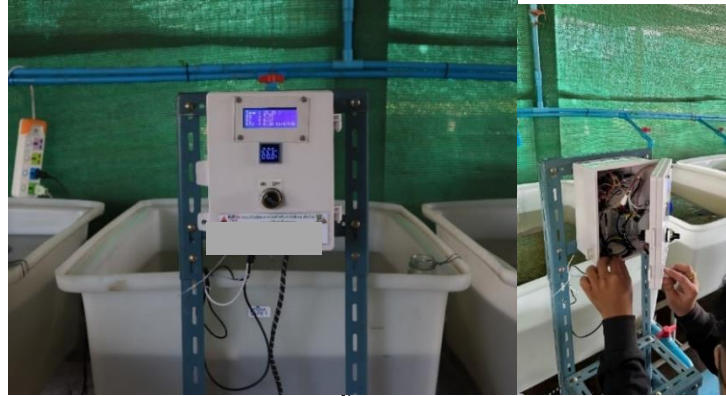
ภาพที่ 6 แสดงการติดตั้งกล่องควบคุมระบบ
